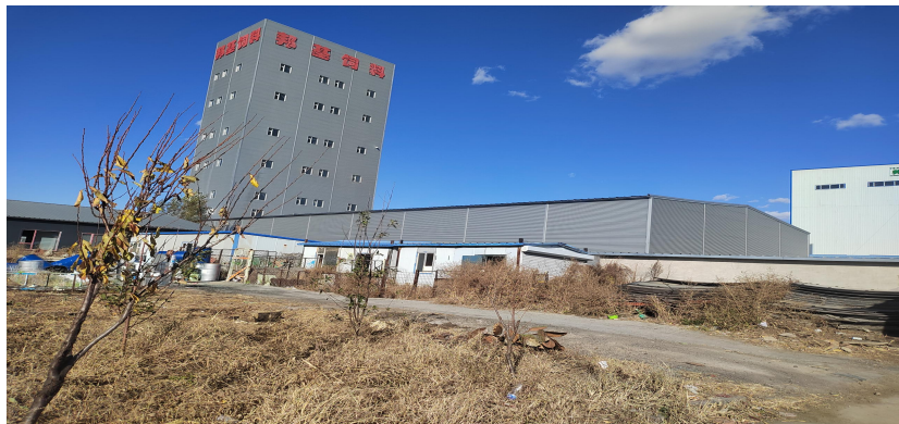
东侧为长春邦基宏运饲料有限公司厂房
