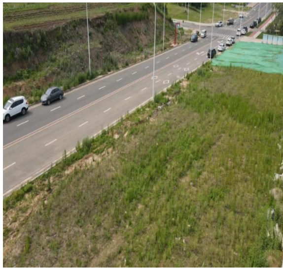
厂界西侧劲松街
